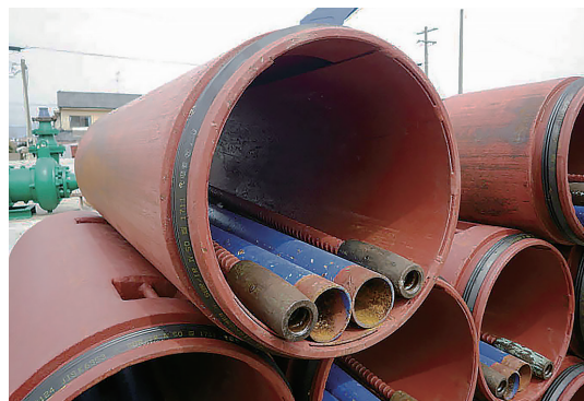
写真－3 KB推進管仮置き状況
