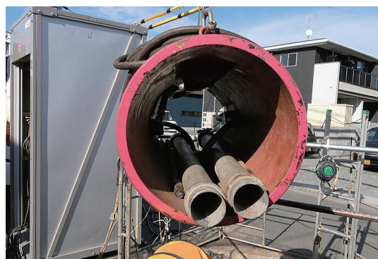
写真－4 KB推進管吊下し状況
