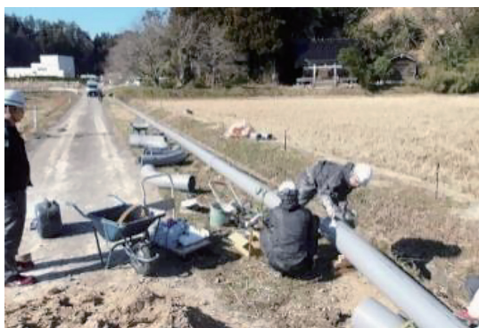
写真-1 下水を集約し処理場に送る圧送管の被災現場
