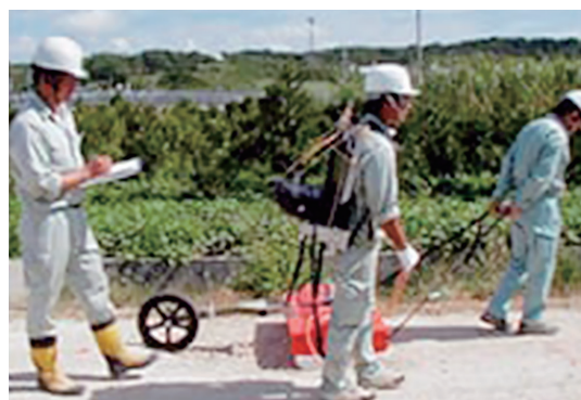
写真-3 地中レーダ探査状況
