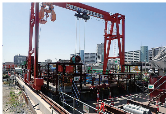
写真-1 No.1 発進立坑全景
