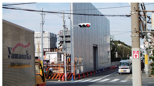
写真-1 BSK-Aタイプ（水道工用 防音壁） 防音低減効果の目安：最大－15dB程度
