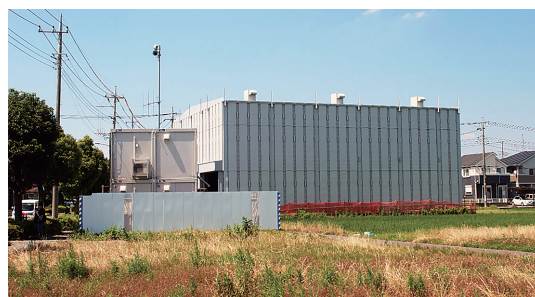
写真-2 BSK-Bタイプ（水道工用 ユニット式防音ハウス） 防音低減効果の目安：最大－30dB程度
