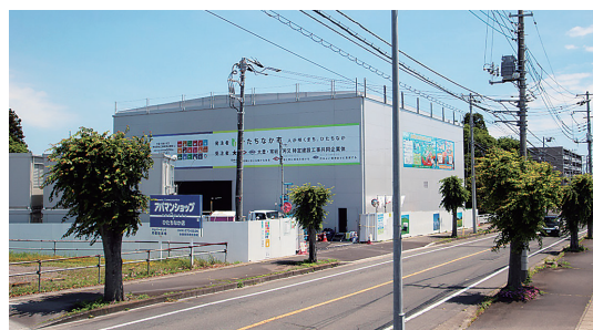
写真-3 新型BSK-Bタイプ（雨水対策用 防音ハウス） 防音低減効果の目安：最大－30dB程度
