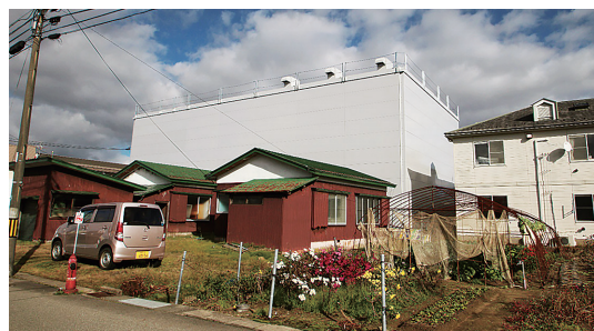
写真-4 BSK-Cタイプ（水道工用 高性能防音ハウス） 防音低減効果の目安：最大－35dB程度
