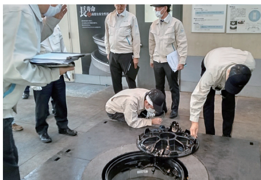
写真－1 下水道用資器材性能確認等審査委員会による審査状況
