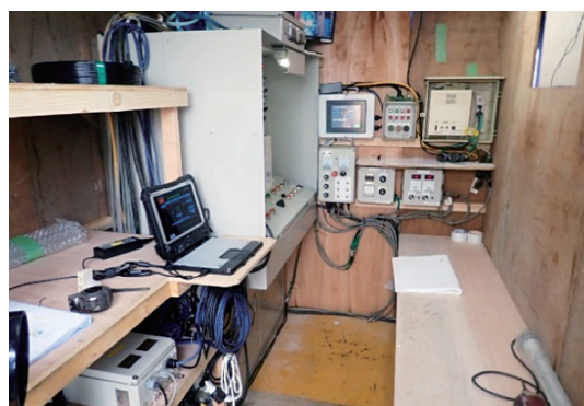
写真-2 掘進機遠隔操作室状況
