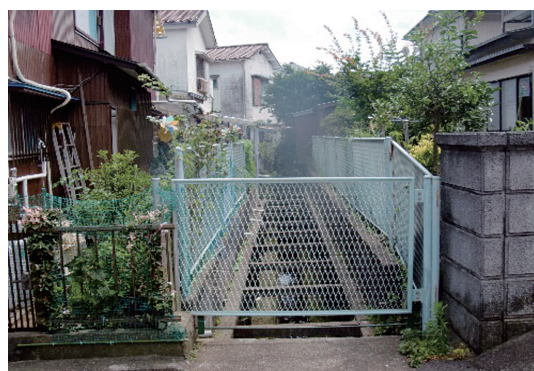
写真-1 既存水路の状況（家屋の近接）
