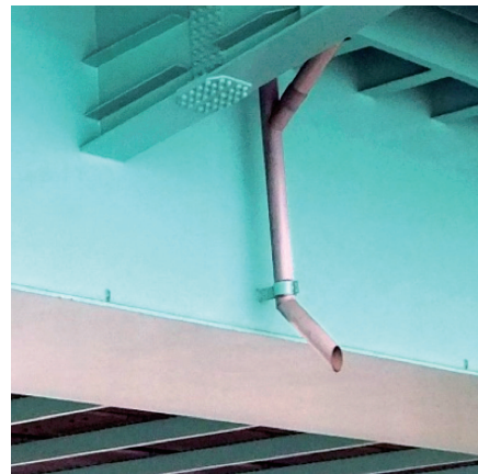
写真-2 橋の上の雨水は川へ
