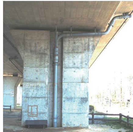
写真-1 高速道路の雨水は下水道管へ
