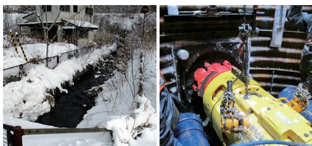
写真-2 室蘭市推進工事 横断河川と初期推進状況
