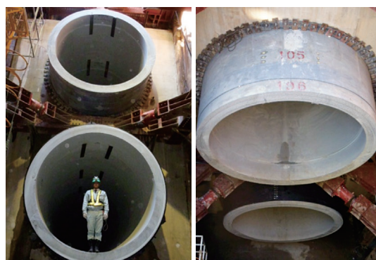
写真-1 上下2段推進完了
