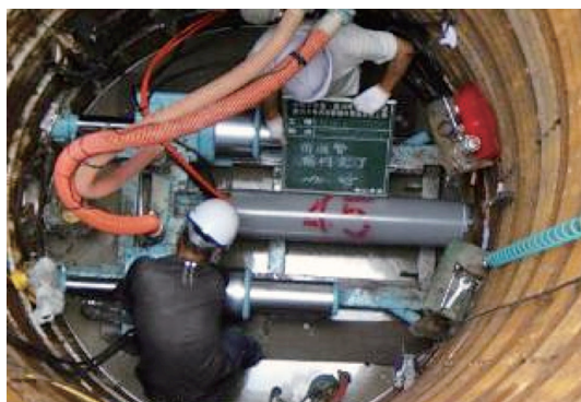
写真-1 推進工 最終管据付状況
