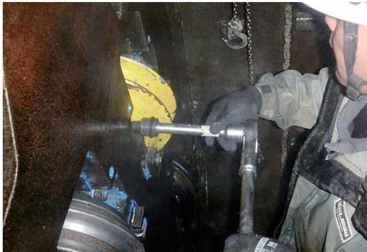
写真-1 ローラビット交換作業
