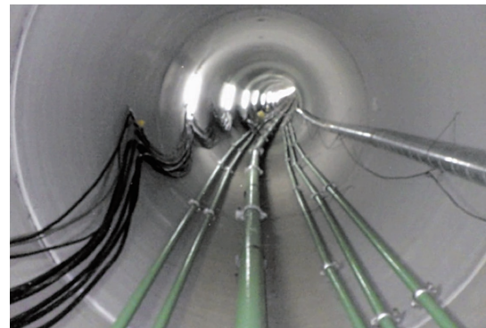
写真-1 複合曲線区間推進管内
