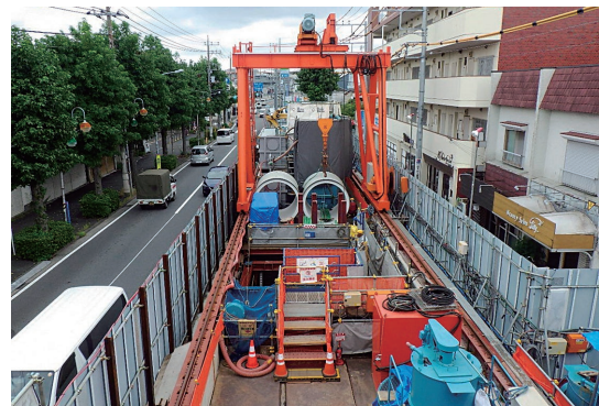
写真-1 本市発注工事における施工状況例
