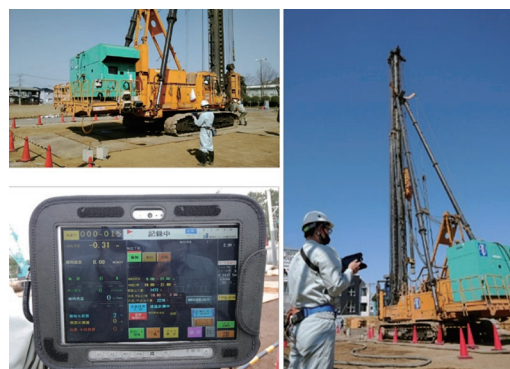
写真-1 施工管理装置のタブレット化
