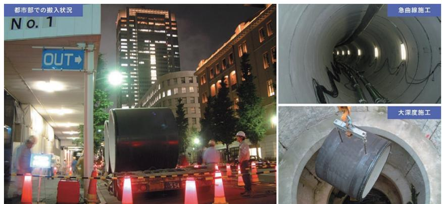
写真-1 合成鋼管採用状況
