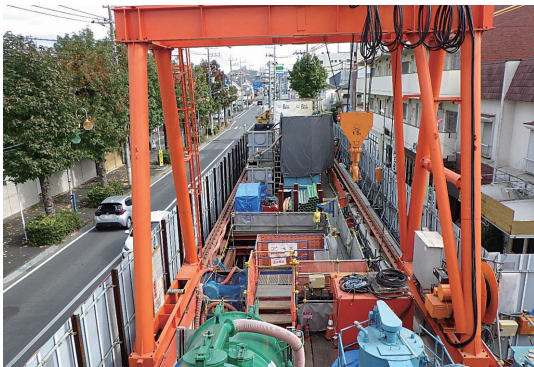
写真-1 狭い発進ヤード
