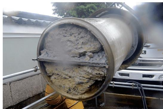
写真-2 シールドコア削孔（1回目）（セグメント部）
