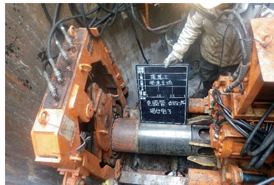
写真-3 先導管据付状況
