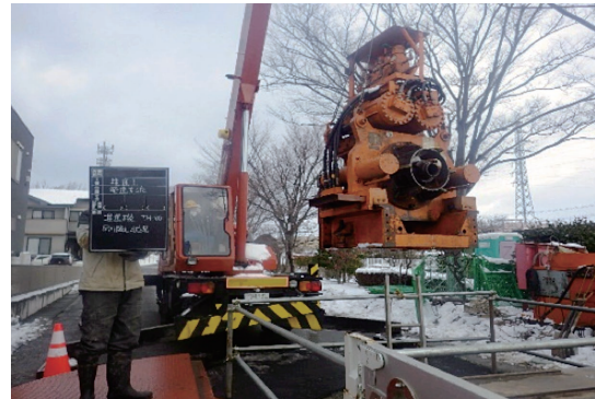
写真-1 推進設備吊下し状況
