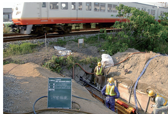
写真-5 小口径ラミング工法 施工状況
