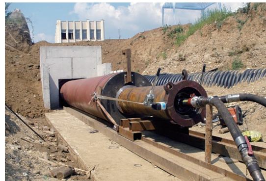
写真-4 大口径ラミング工法 施工状況
