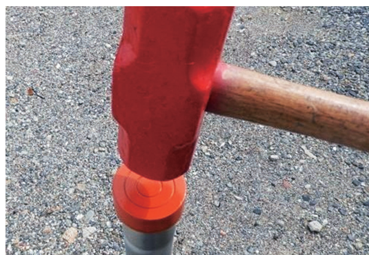
写真-1 単管パイプをハンマで打ち込む様子
