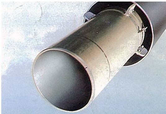
写真-1 鋼製さや管推進工法 さや管挿入後イメージ
