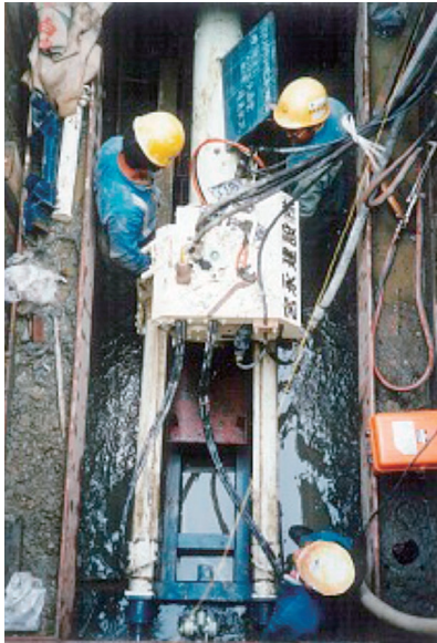
写真-1 エンビライナー工法1号機試験施工状況
