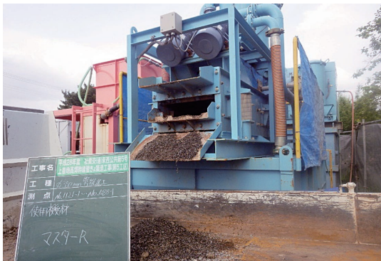
写真-2 連続土砂分級装置マスター R設置状況
