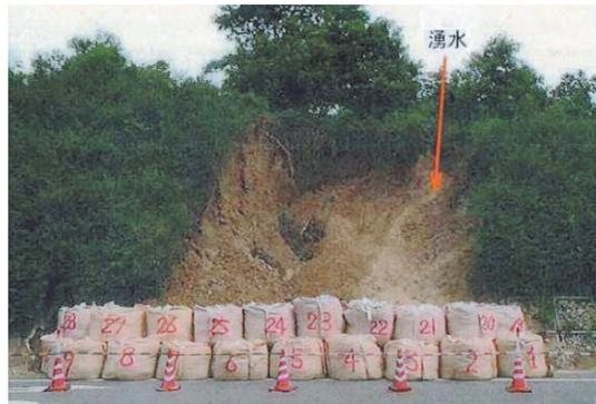
写真-1 法面崩壊の一例<sup>3)</sup>
