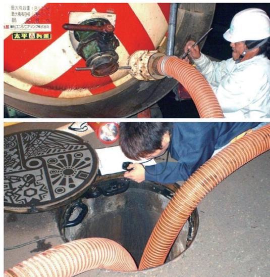
写真-2 流量計の精度の確認。8トンのタンク車2台の水を一気に下水道管に流して流量計が16m<sup>3</sup>と観測できるかテストした上：8トンのタンク車、下：放流先のマンホール
