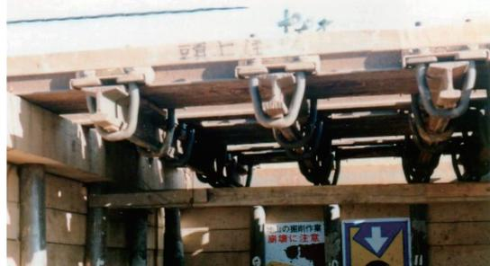
写真-2 軌条桁による列車荷重の仮受けの例
