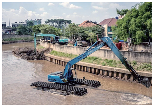
写真-2 浚渫によるジャカルタ市内洪水対策
