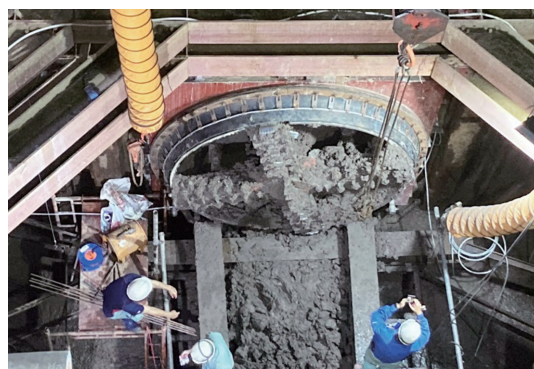
写真-3 推進呼び径2200到達
