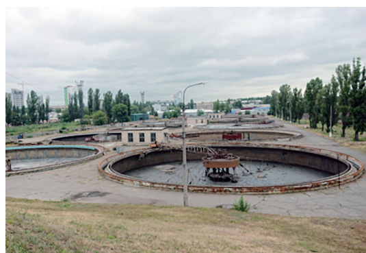
写真-1 老朽化した沈殿池
