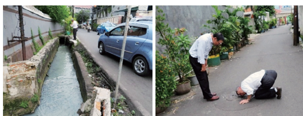
未処理下水（白濁した生下水） 汚水流下状況の確認 写真-1 汚水収集状況（供用25年後）
