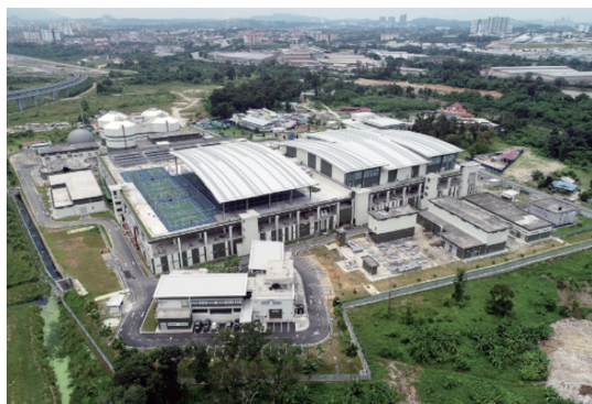
写真-1 ランガット下水処理場
