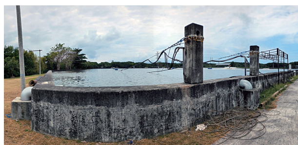
写真-2 Suwung処理場 (エアレーテッドラグーン方式)
