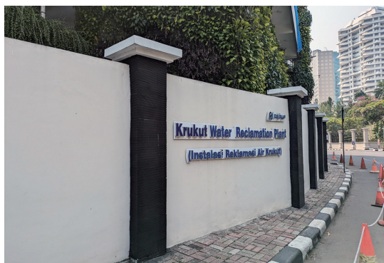
写真-1 第0区の下水処理場 (krukut処理場)
