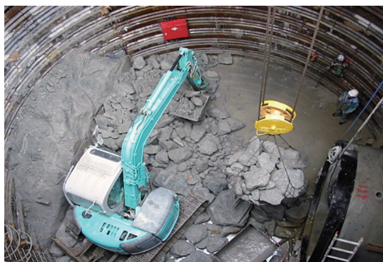
写真-1 従来の支圧壁・破碎、処分
