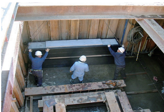
写真-3 バックロック設置状況
