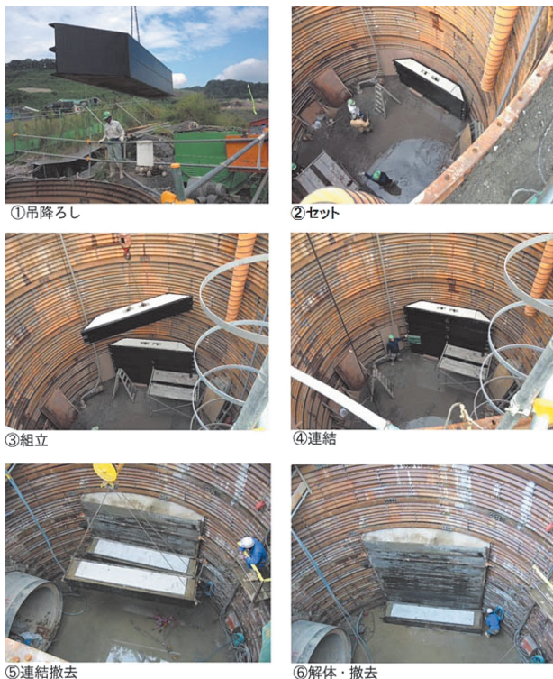
写真-2 バックロック作業工程
