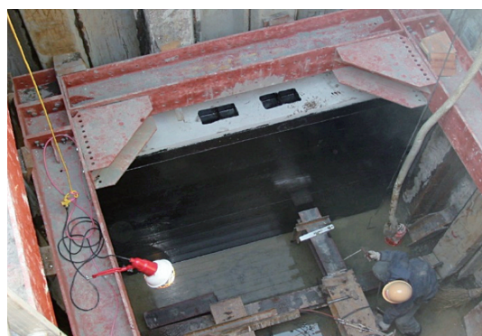
写真-4 バックロック使用状況
