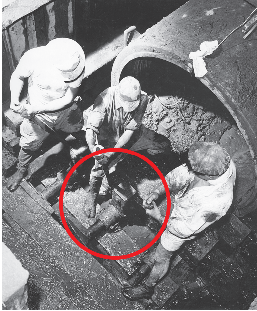
写真-1 手押し式油圧ジャッキ使用状況
