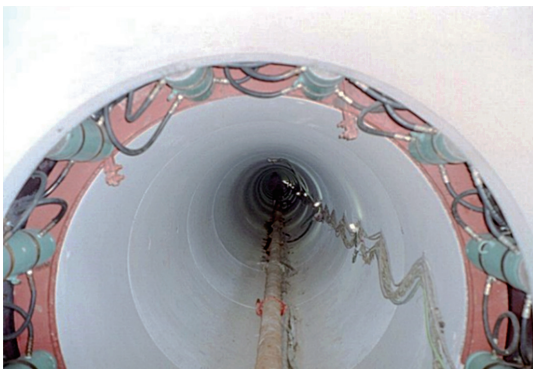
写真-4 中押装置設置状況
