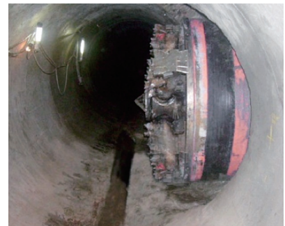
写真-3 シールドトンネル到達
