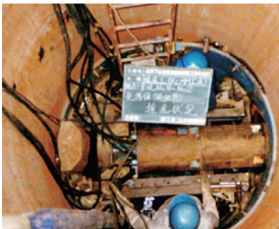
写真-1 ケーシング立坑
