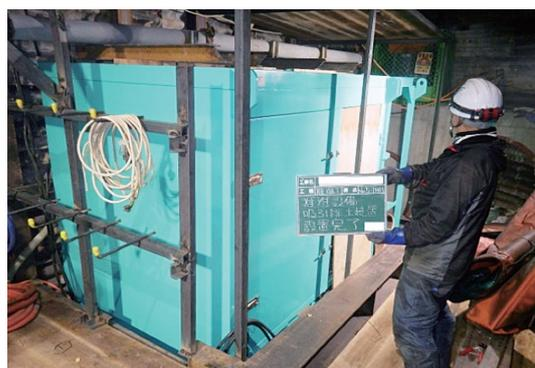
写真-2 発進立坑内に吸泥排土装置設置
