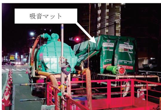
写真-1 吸音マットを設置した発電機
