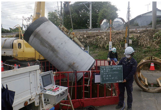
写真-1 推進管（標準管）吊降ろし状況
