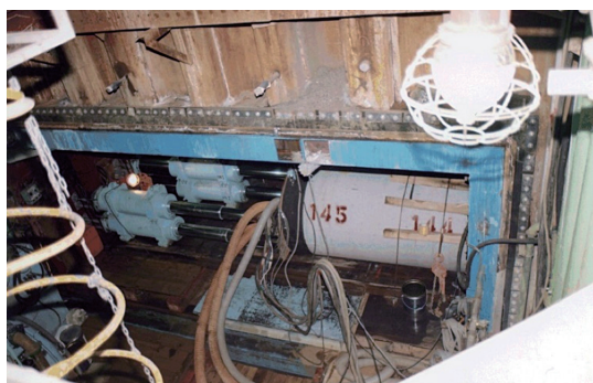
写真-1 ステーション正面
