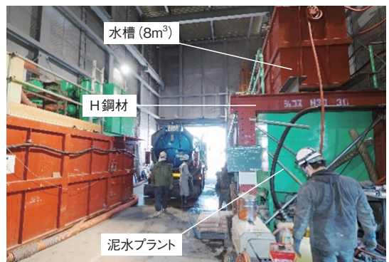
写真-2 泥濃式呼び径3000での二階建てプラント例
