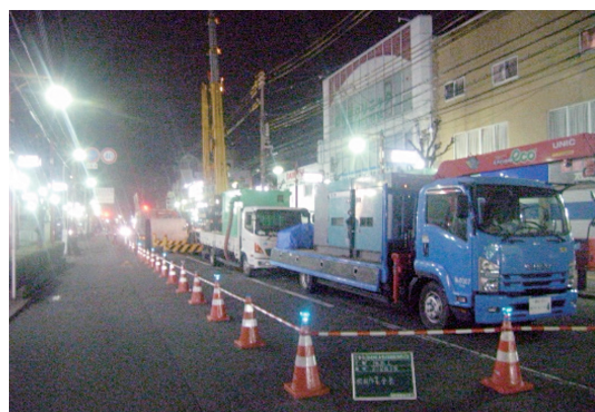
写真-1 泥濃式呼び径1800での車上プラント例
