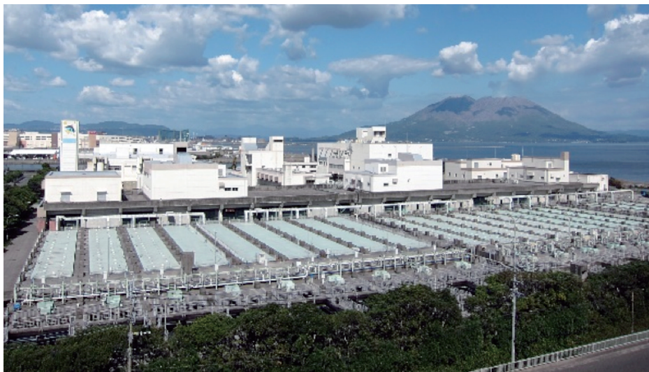
写真-1 南部処理場
