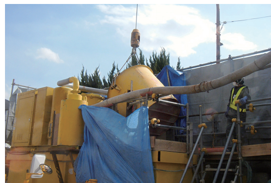
写真-3 立坑上の排土貯留槽
