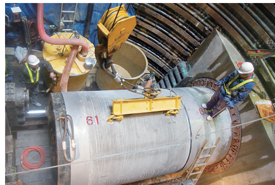
写真-2 立坑内の丸タンク
