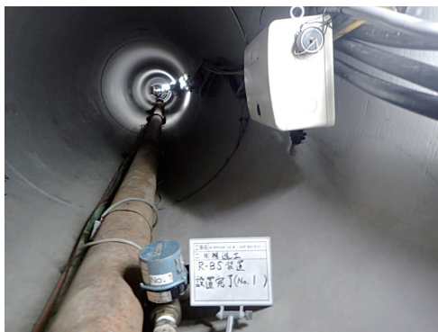
写真-1 R-BS設置状況
