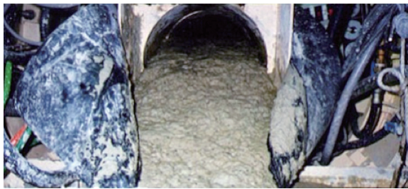
写真-1 掘進機内での排土状況（砂礫層）
