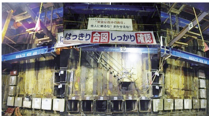
写真-1 つくばエクスプレス六町駅(先受けエレメント推進工事)：駅舎
