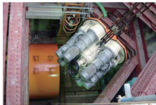
写真-4 現場での掘進機駆動部吊り下し状況
