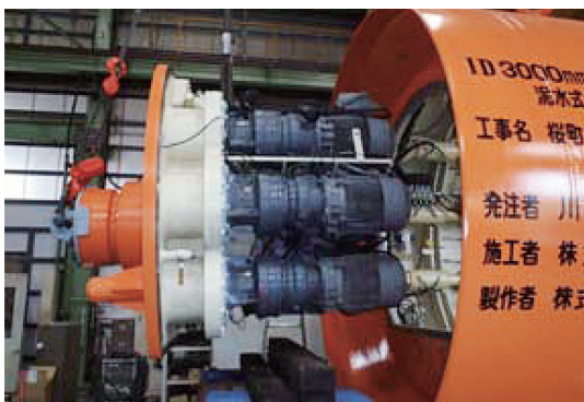
写真-2 工場での掘進機駆動部解体状況②
