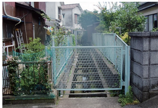
写真-1 既存水路の状況（家屋の近接）
