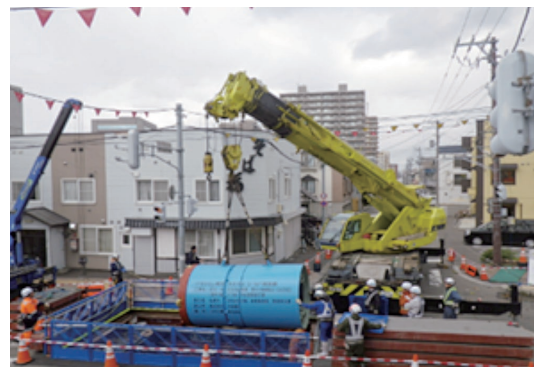
写真-1 住宅街の施工状況(平岸地区)
