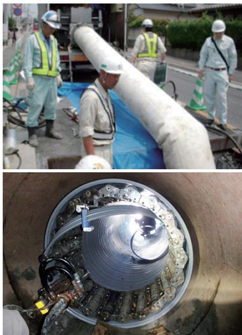
写真-1 管路更生工法の施工状況例
