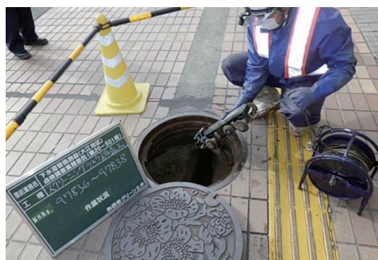
写真-1 管きよのスクリーニング調査
